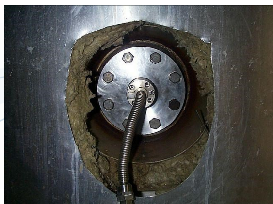
Montage sur cuve
